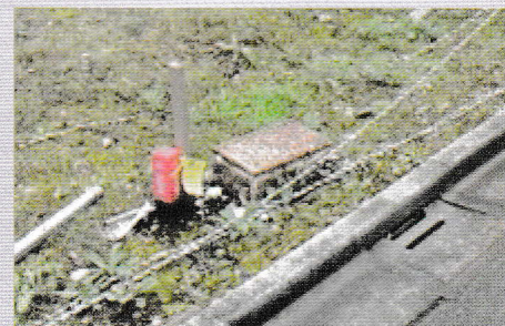
▲ 使用見込みがないまま放置されている給水管
